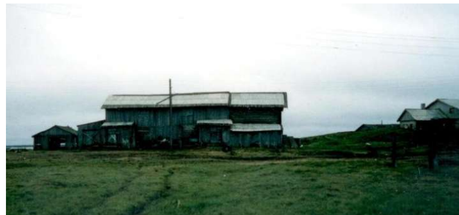
Чердынский амбар постройки 1899 г. д. Андег.
